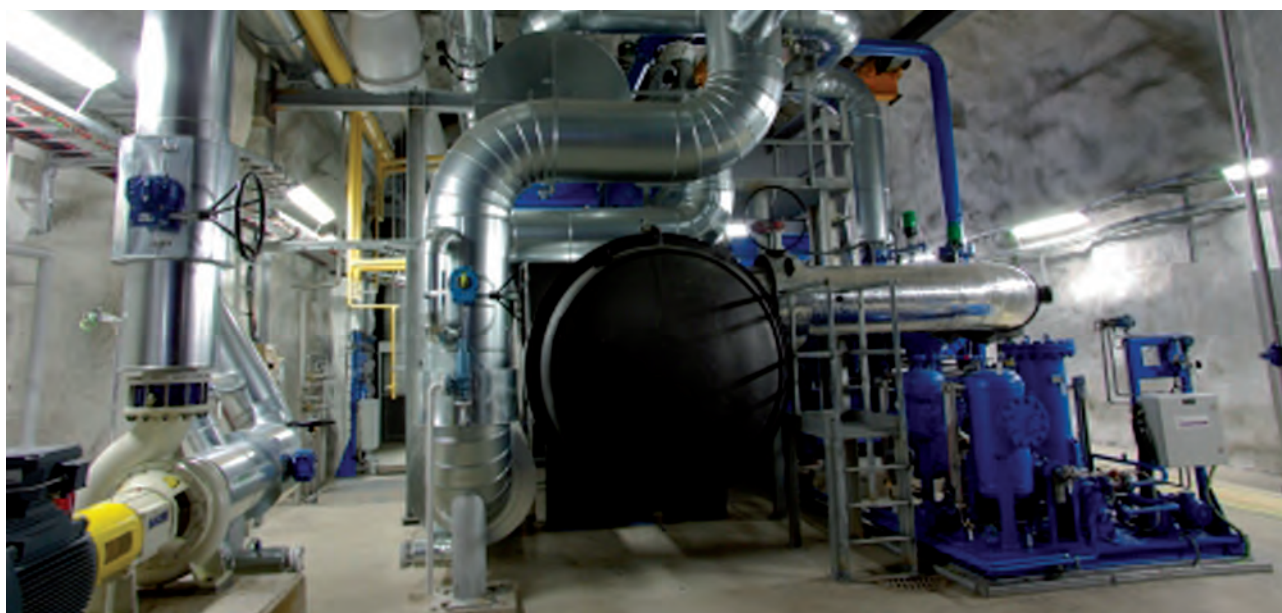
„Катри Вала“ - највеће постројење са топлотном пумпом у свету, које обједињеним процесом производи и даљинско грејање и хлађење.
