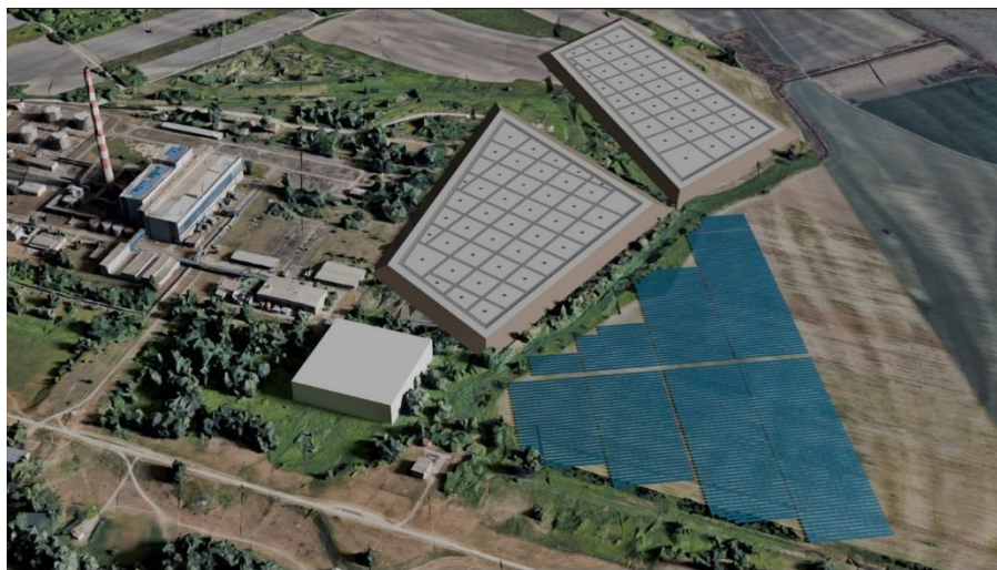
Slika 1-2: Vizualizacija budućeg solarno-termalnog sistema (uključujući severno i južno sezonsko skladište toplotne energije, solarno kolektorsko postrojenje i tehničku zgradu)
